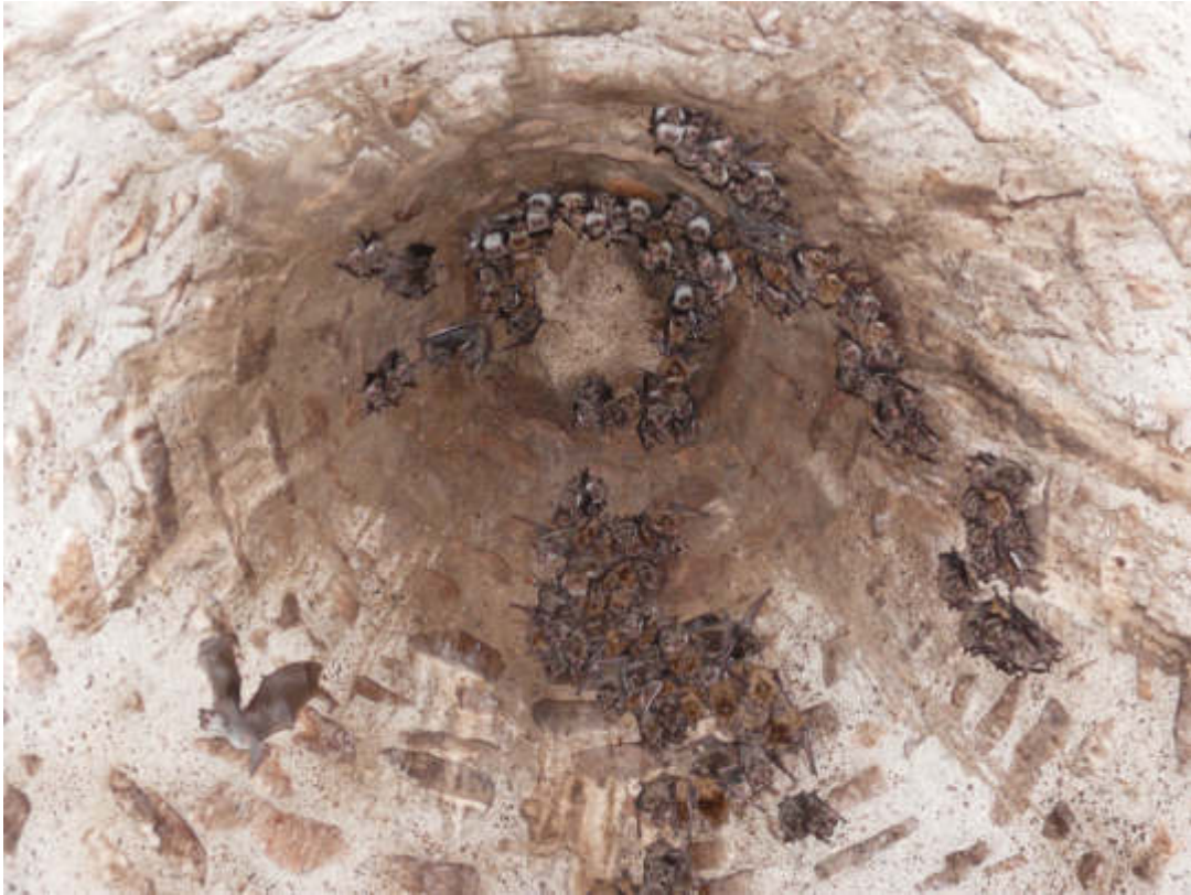
Abb. 10: Mausohren unter dem Betondach, Hangplatzzählung am 20.7.2022
