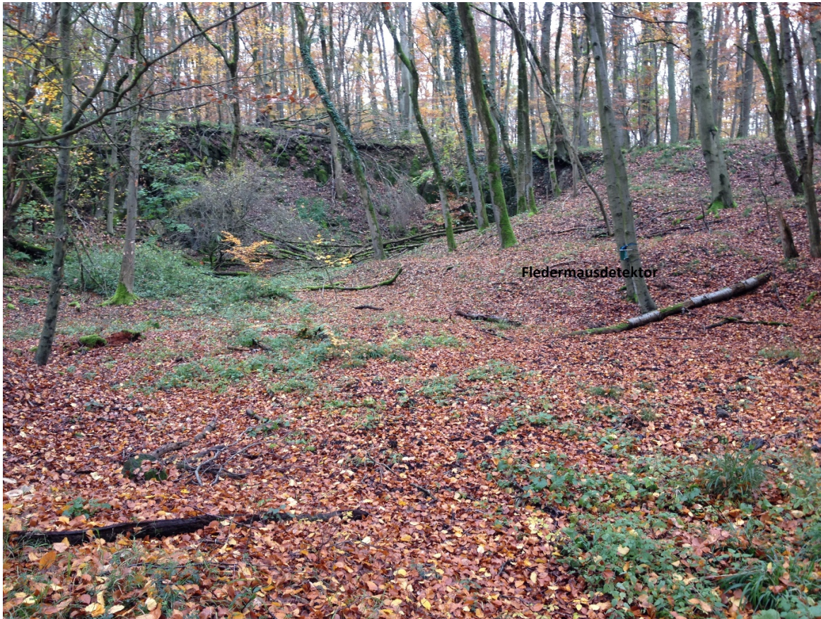
Bild 1: Standort des Fledermausdetektor im alten Steinbruch
