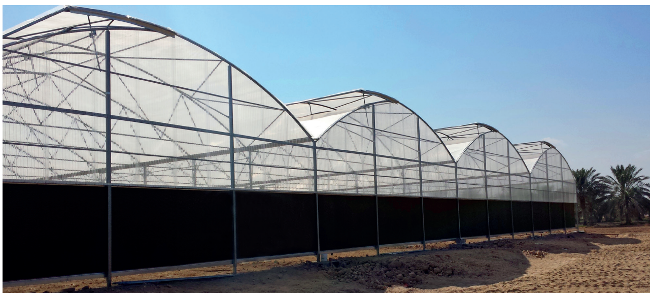
Impianti di raffreddamento / Cooling system
