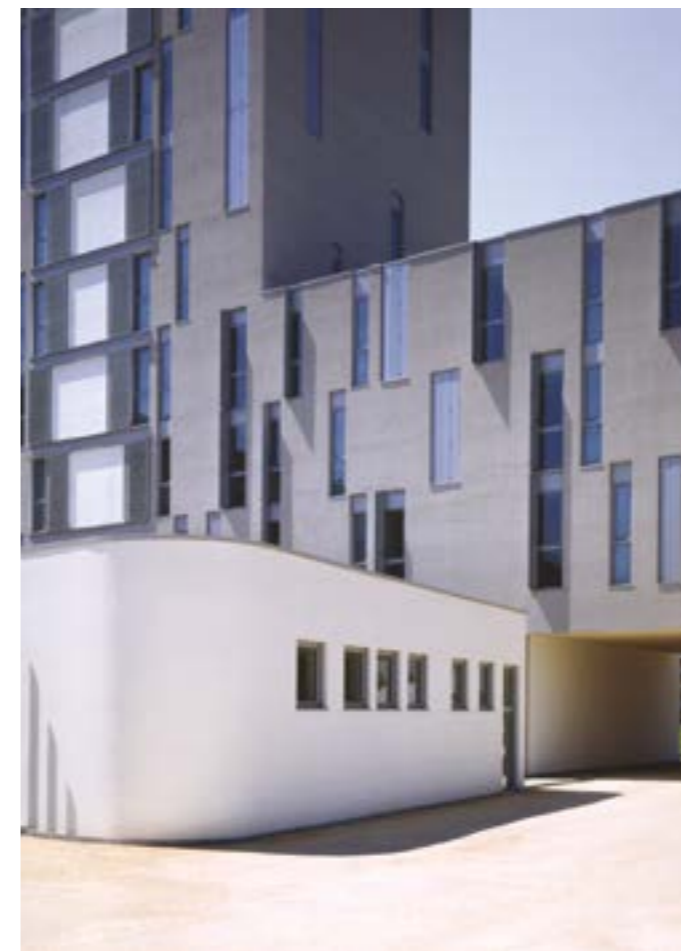
Complesso di via Gallarate
