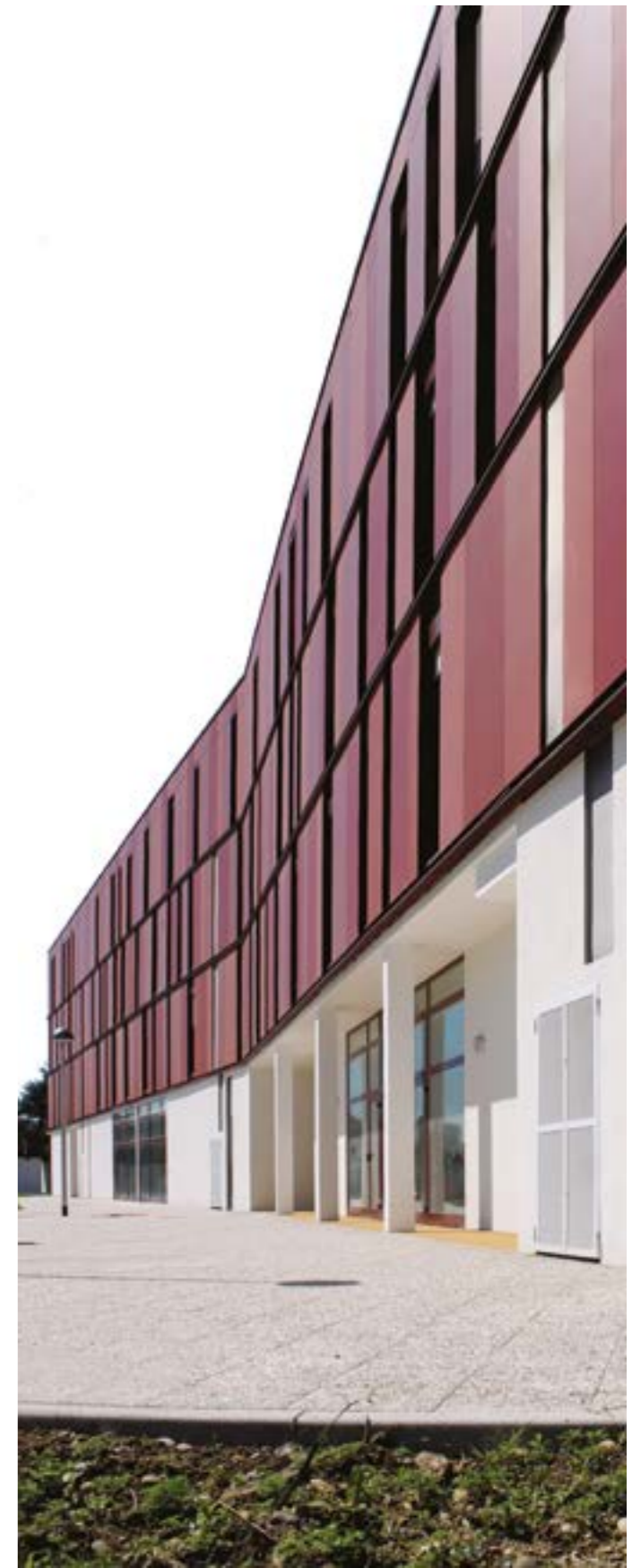
Edificio del complesso di via Senigallia
