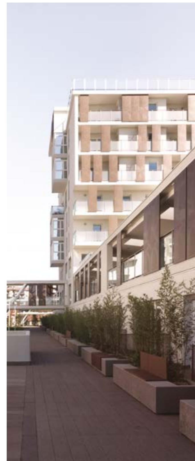
Cenni di Cambiamento, complesso residenziale di via Cenni
