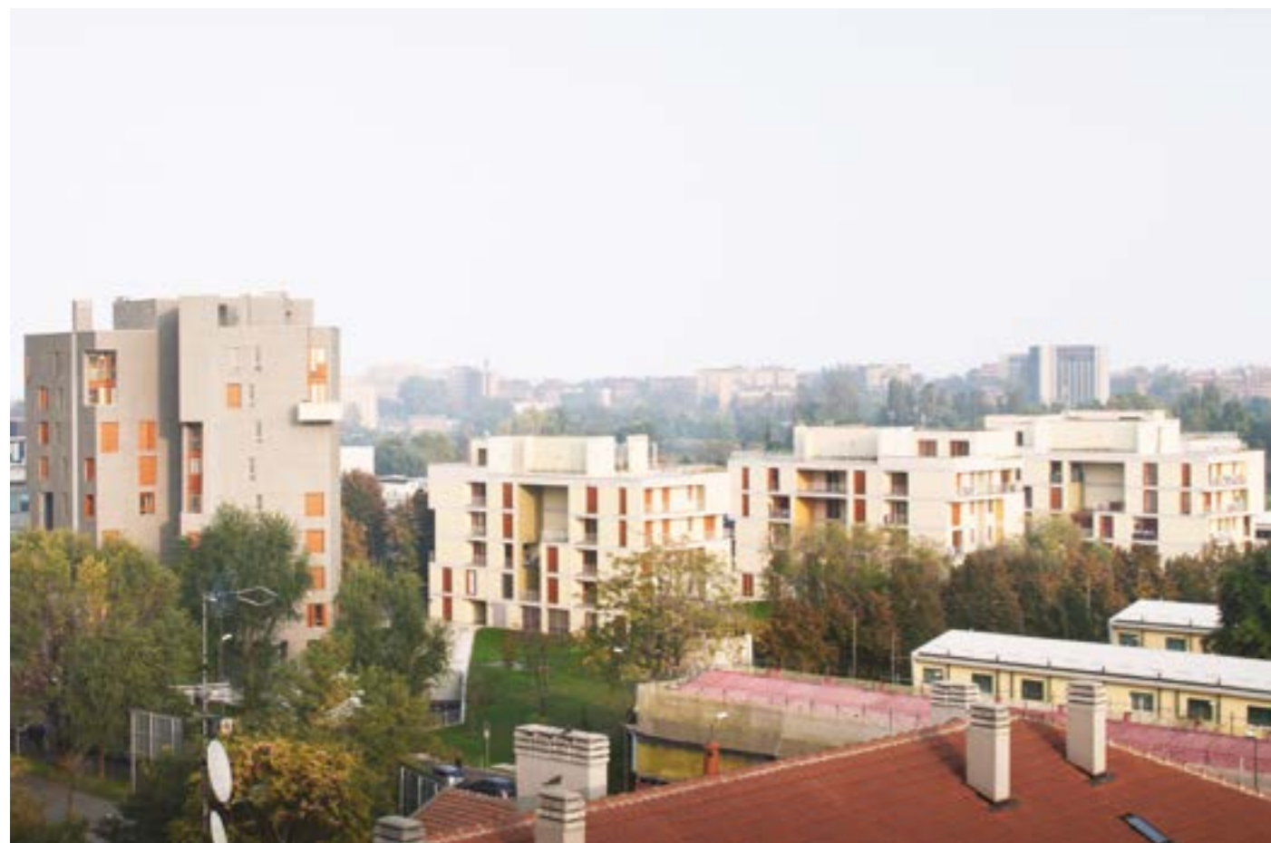
Vista aerea del quartiere di via Civitavecchia
