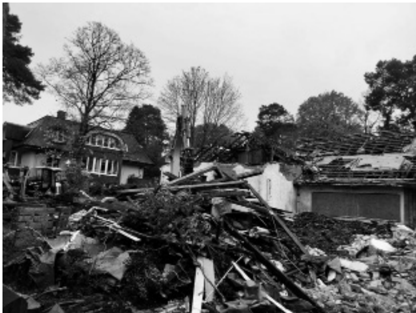
Abriss Haus Marlene Poelzig am 1. November 2021
