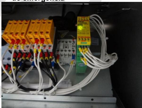
Funcionamento do relé da chave de segurança com duplo canal e dos botões de emergência
