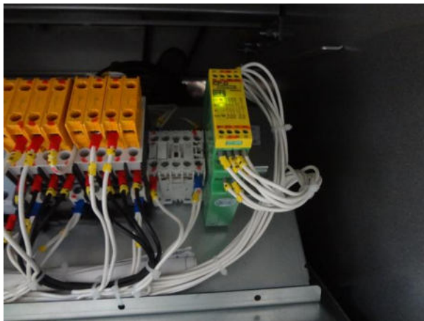
Funcionamento do relé da chave de segurança com duplo canal e dos botões de emergência
