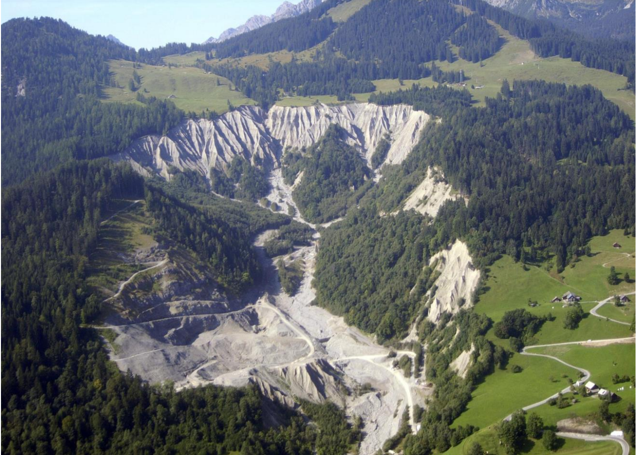
Abbildung 2 Schrägluftbildaufnahme des Schesatobel mit Blickrichtung Süden (Quelle: Raumplanung/ Land Vorarlberg)
