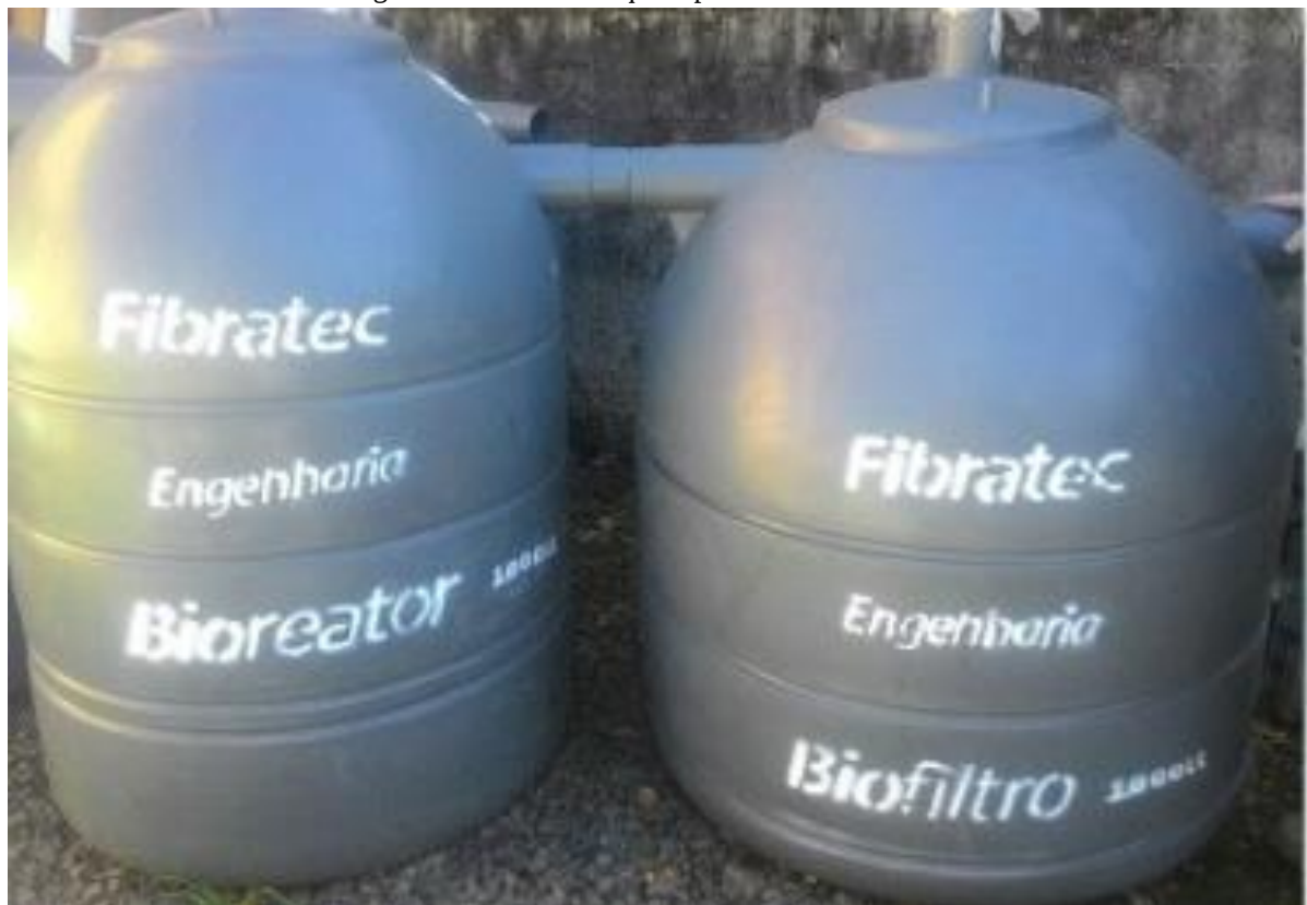
Figura 21 - Sistema tanque séptico e filtro anaeróbio.
