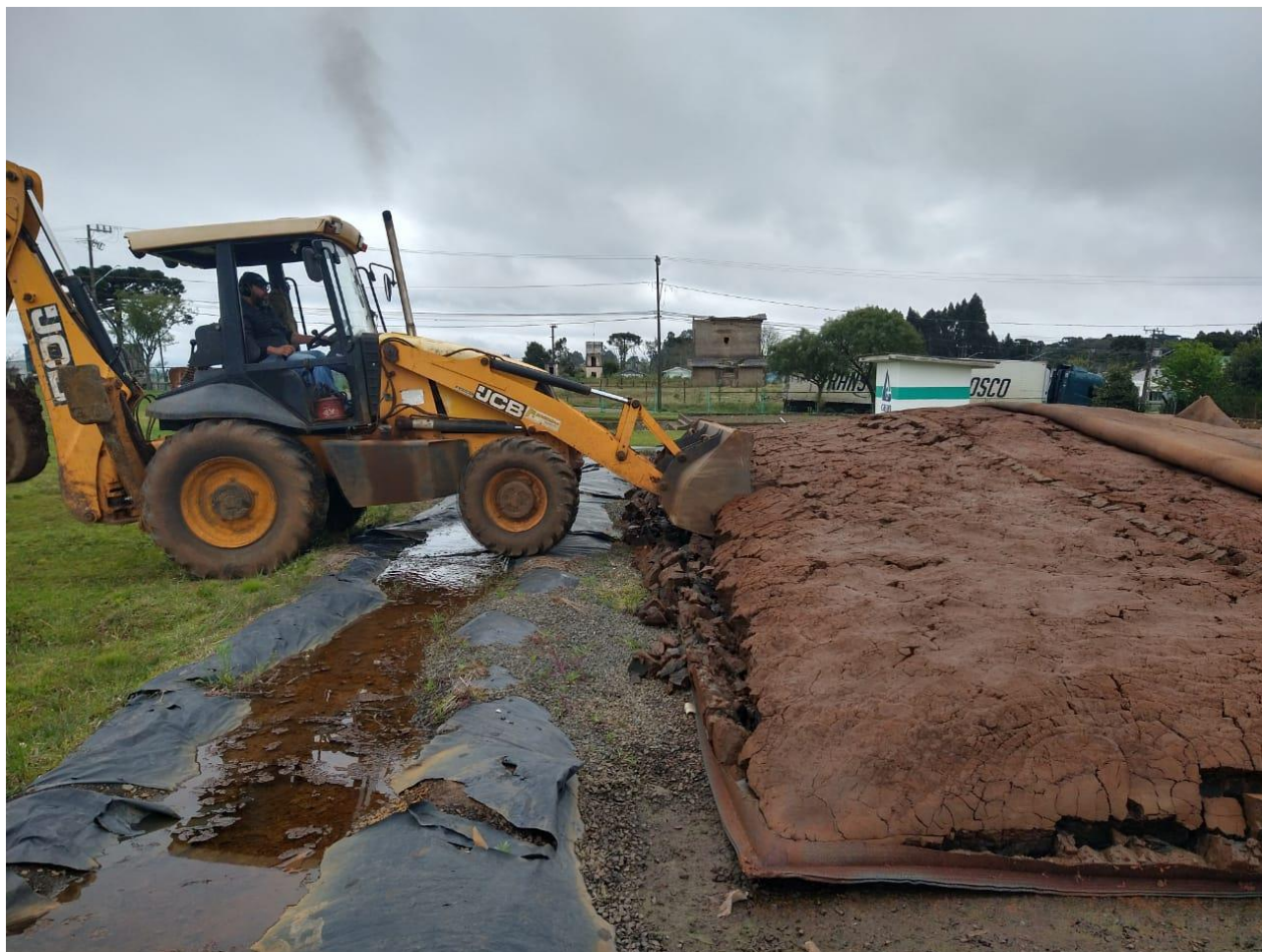
Figura 9 – Aspecto visual do lodo obtido após desidratação em bag geotêxtil na ETA de Curitibanos.
