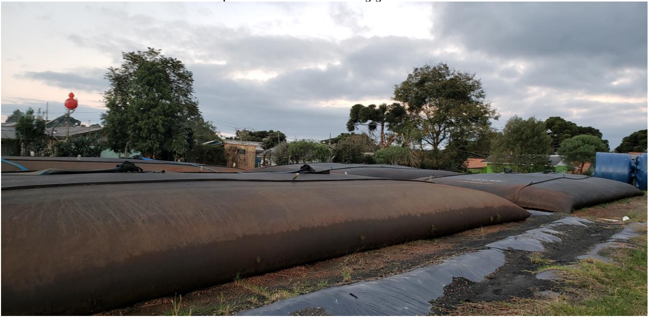
Figura 10 – Bag geotêxtil de 250 m 3 instalado no município de Curitibanos. Detalhe para a camada de drenagem em pedra britada abaixo do bag geotêxtil .
