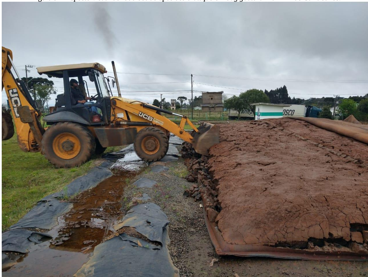
Figura 9 – Aspecto visual do lodo obtido após desidratação em bag geotêxtil na ETA de Curitibaanos.
