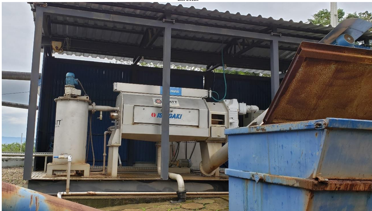
Figura 11 – Exemplo de prensa desaguadora de discos (ao centro) instalada em uma ETA na região sul de Santa Catarina. Detalhe para o tanque de mistura com polímero à esquerda e container para recebimento do lodo desidratado à direita.
