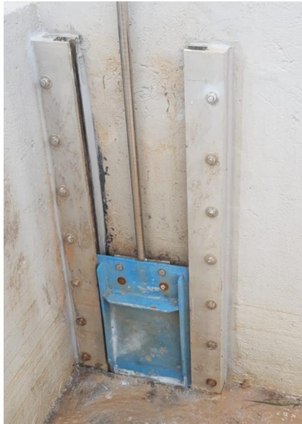
As comportas de fundo, são construídas para serem instaladas no fundo do canal.
