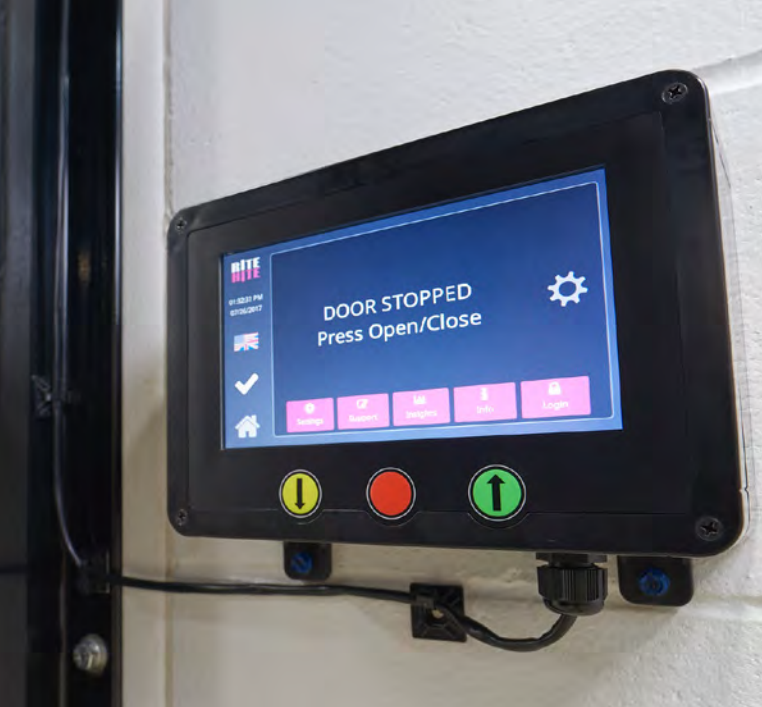
Deze GUI-bedieningskast (grafische gebruikersinterface) voor de deur verstrekt waardevolle gegevens en kan worden geïntegreerd in een gebouwmanagementsysteem
