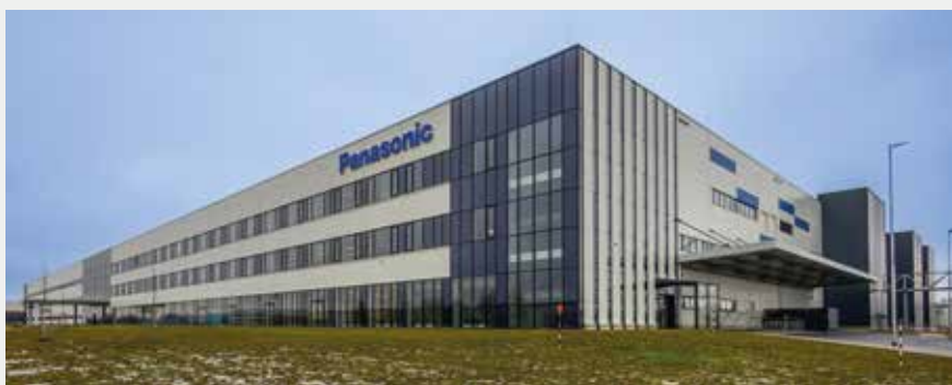
Sito produttivo delle pompe di calore aria-acqua Panasonic. Pilsen, Repubblica Ceca. VRF, unità rooftop e chiller.
